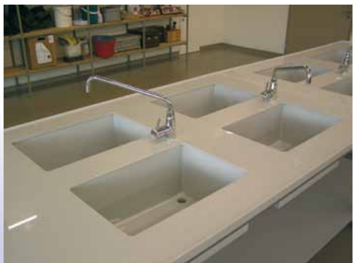
Spültisch im Stadion Maladière in Neuenburg im Lokal des Service Incendie et Secours
